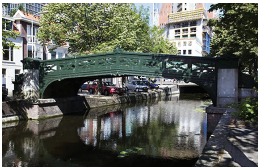
Een gietijzeren brug in den Haag
