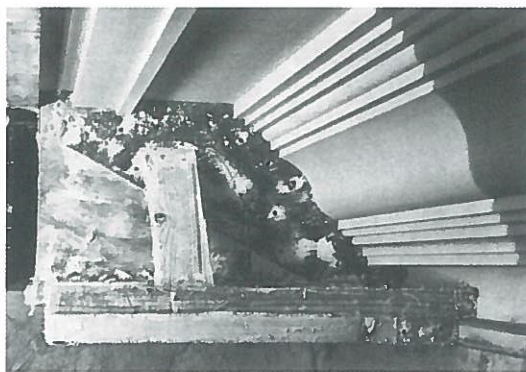
Het resultaat, als de stucmal langs de vastgemaakte glijlatten is getrokken
