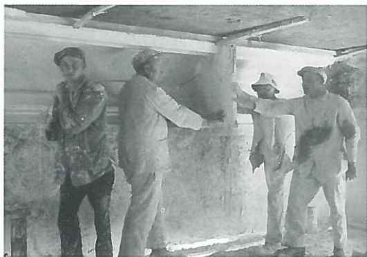
Het trekken van het profiel is in volle gang
