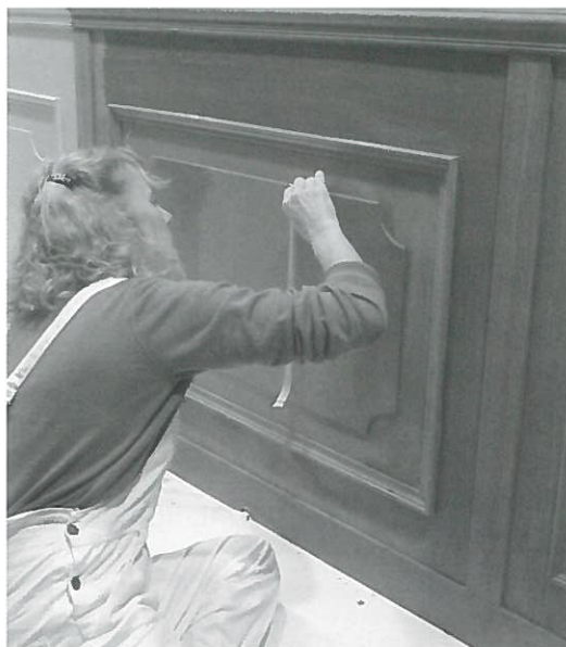
Bijwerken voor het aanbrengen van de eindvernisl laag
