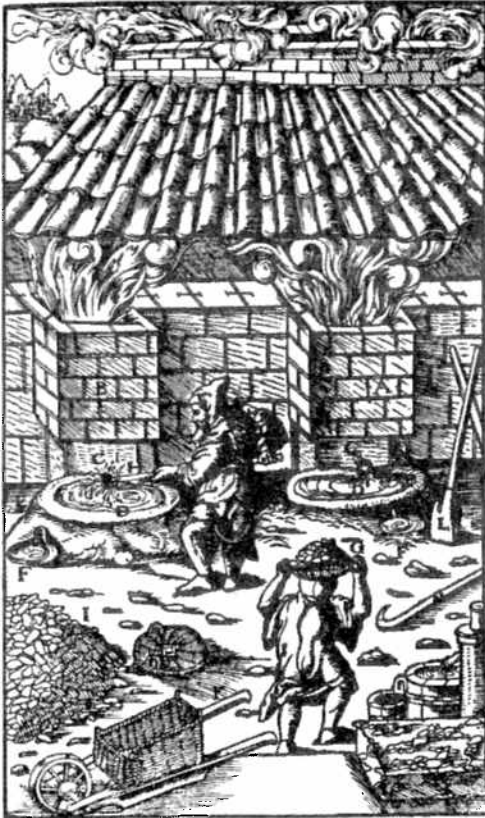
Kopersmeltoven uit de 16de eeuw. Uit: Georgius Agricola, De Re Metallica , Bazel
