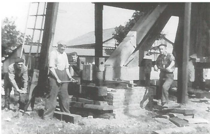
De Vlaamse molenbouwer Omer Vandenbussche vijzelt een standermolen op voor herstelwerkzaamheden (collectie Frans Weemaes, Stichting Levende Molens Roosendaal).
