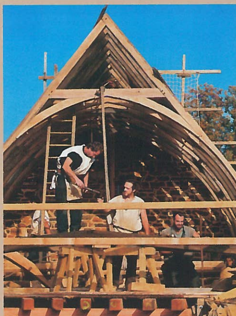
Sporenkap in aanbouw.
